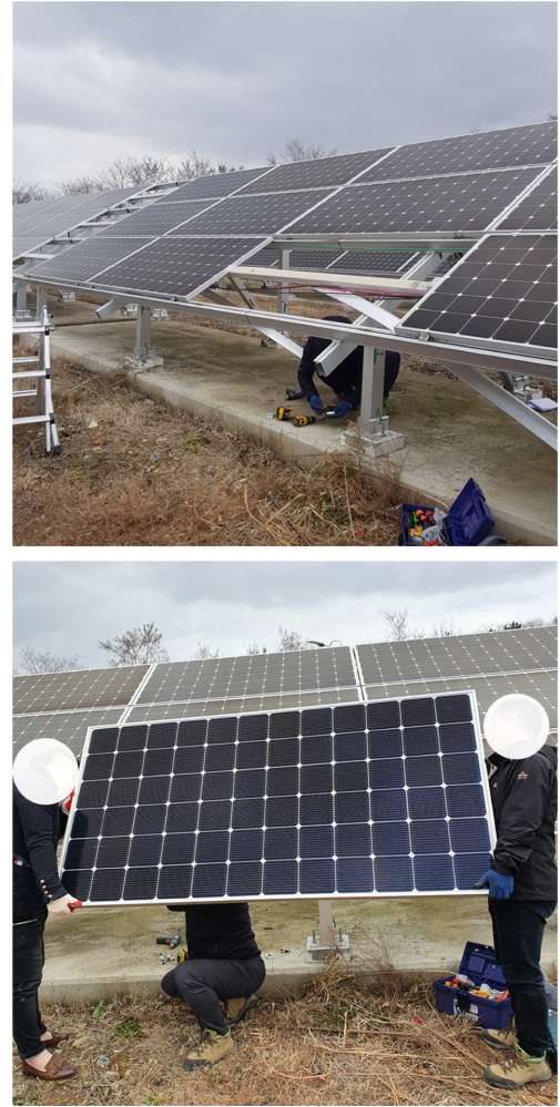
Fig. 11. Changing PV module.
